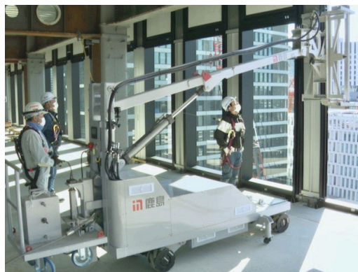
外装部材取付の様子
