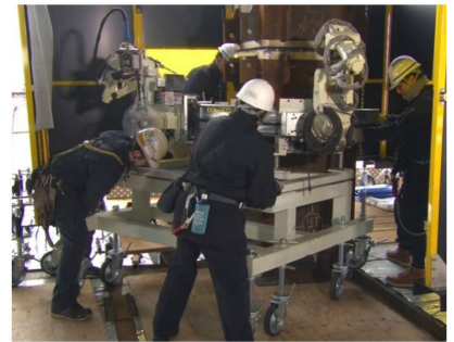
専用台車による設置状況
